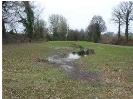
Création d'une noue sur l'emprise des bassins de lagunage
