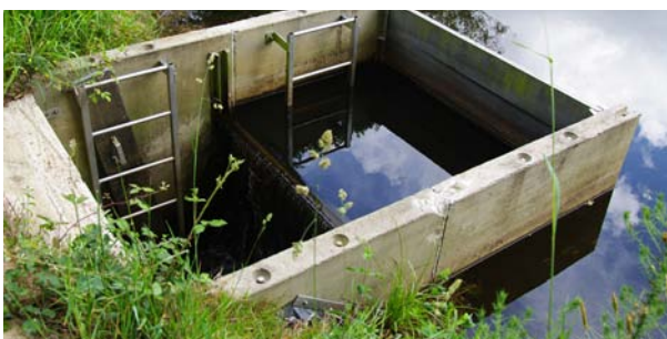
Restauration d'ouvrages hydrauliques
