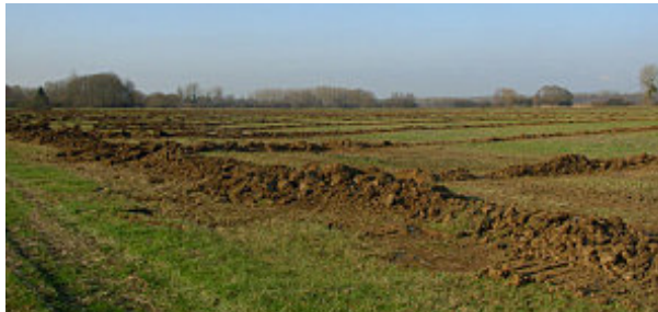
Effacement de drainage
