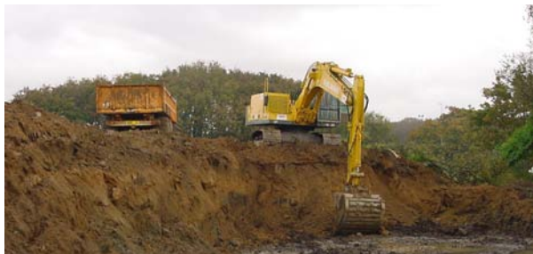
Suppression de remblai en zone humide
