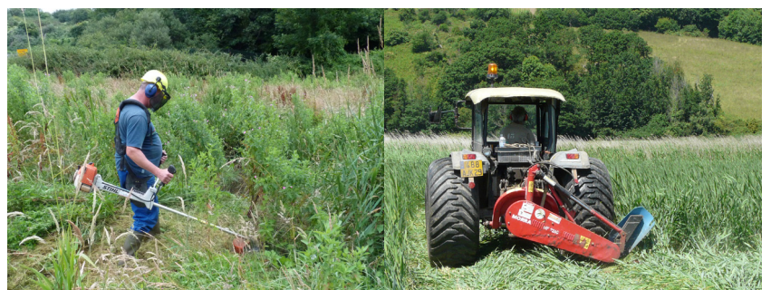
Le recours à des moyens d'intervention légers ou lourds dépend de la taille du chantier, de sa pénibilité, de la portance du terrain
