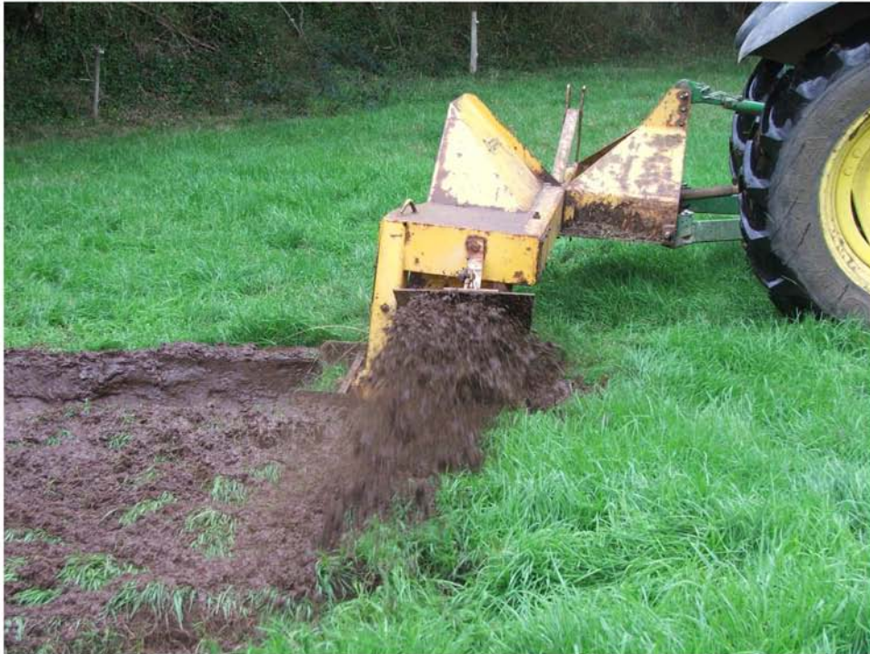
Rototrancheuse en action
