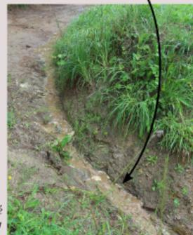
Photo d'un écoulement concentré dans un fossé
