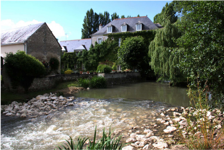
Travaux d'arasement partiel - Indre et Loire (37)
