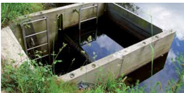
Restauration d'ouvrages hydrauliques
