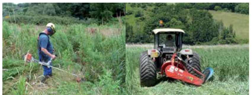
Le recours à des moyens d'intervention légers ou lourds dépend de la taille du chantier, de sa pénibilité, de la portance du terrain
