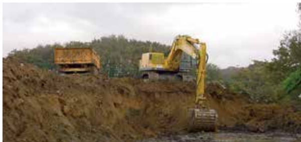
Suppression de remblai en zone humide
