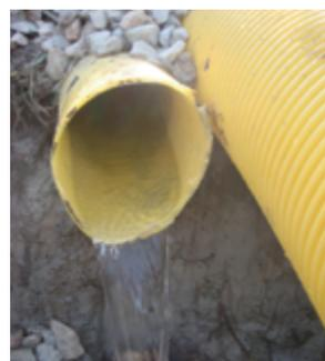
Exemple de drain souterrain
